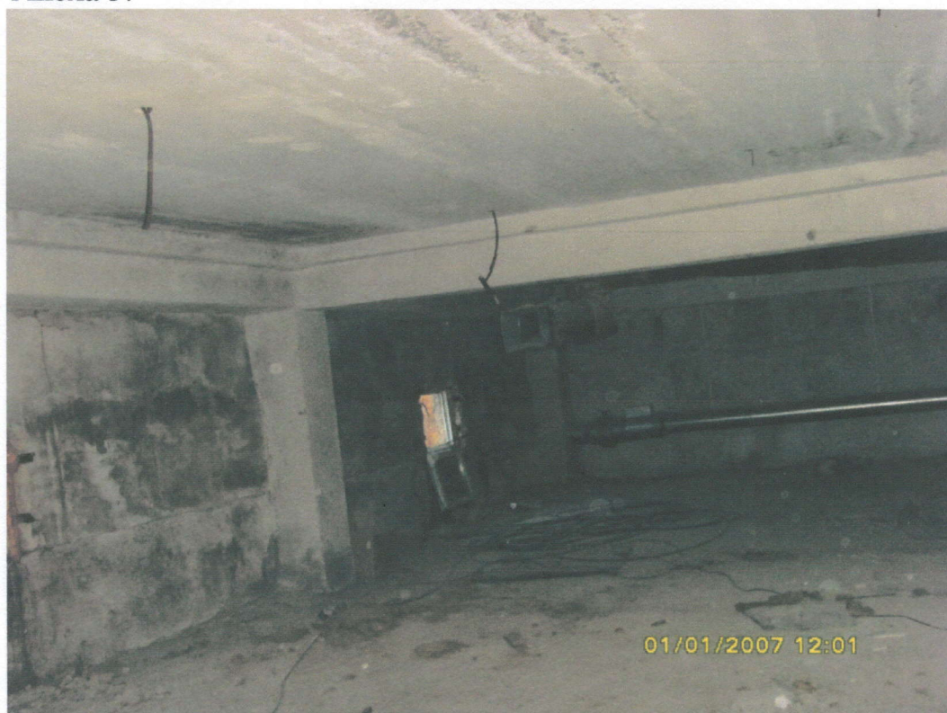
f: Anexa 3: Alcătuire planșeu de pod (în limita etajului tehnic).
