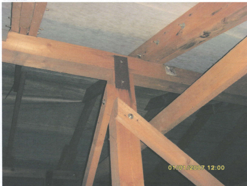
h: Anexa 4: Alcătuire acoperiș șarpantă.
