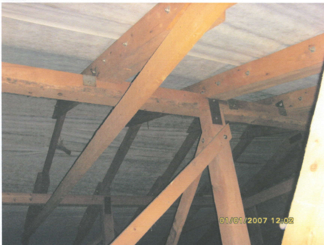
d: Anexa 4: Alcătuire acoperiș șarpantă.
